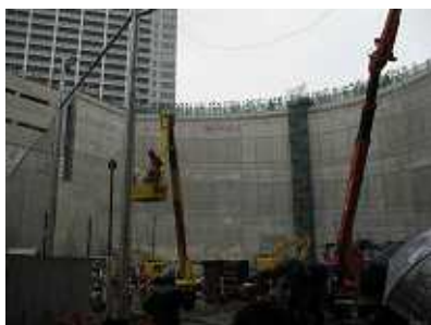
工事が進むジャンクション内広場
